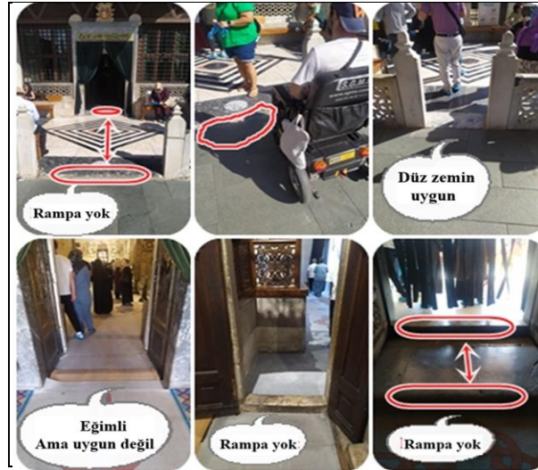
Görsel 7. Mevlâna Müzesi'nde (Mevlâna Türbesi) Erişilebilirlik Sorunları: Rampa Eksiklikleri
